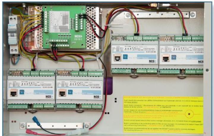
Les automates de sécurité SC4x5™ font partie de la famille SCNET4™ Version 3 de systèmes intégrés de gestion électronique de contrôle d'accès, sûreté de bâtiment et gestion technique. SC4x5™ est adapté aux installations modernes du bâtiment automatisé et sécurisé, aux architectures de réseau les plus variées et au pré-câblage de bâtiment. Il offre une très grande modularité, permettant d'assembler un système comme "un jeu de cubes".
